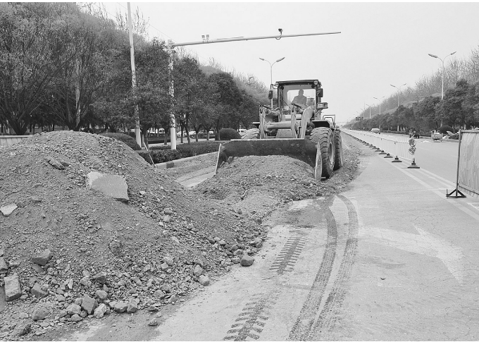
淞江南半幅已经开始维修。
