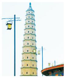
日前,经过最新勘察测量结果显示,被誉为"中国最高古砖塔"的山西汾阳文峰塔已向东倾斜1.82米(如图)。
