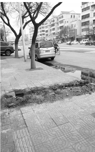
路上污水。见习记者 王麓棣 摄
