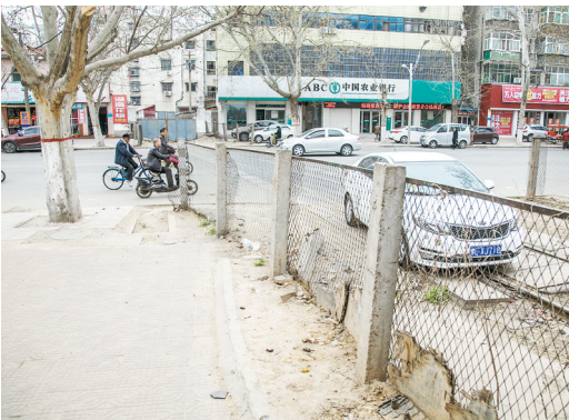
废弃道口阻挡了人行道。
