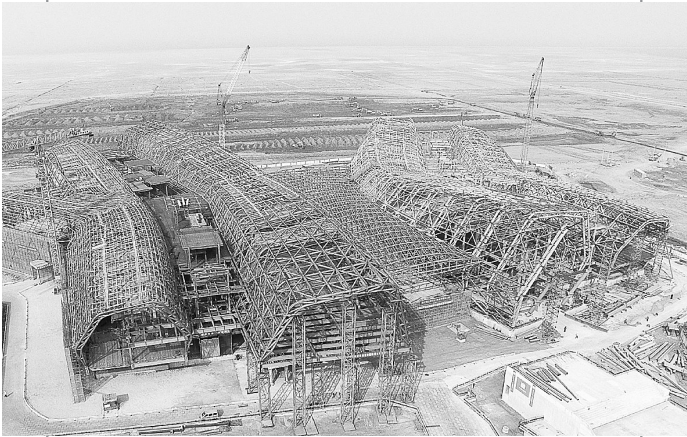
近日，由中国建筑第八工程局有限公司施工的国家海洋博物馆主体结构基本完工，“鱼跃”外观初现雏形。国家海洋博物馆是中国首座国家级综合性、公益性的海洋博物馆，坐落于天津滨海新区中新生态城滨海旅游区域，总投资逾20亿元，总建筑面积8万平方米。预计今年底全部建成，2017年5月开馆试运行。
