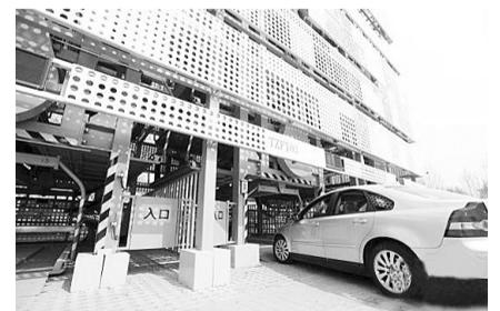
4月5日,位于北京新城通州区的“垂直循环式立体车库”试点工程完工等待验收。这是北京一家民营工程企业生产研发的“垂直循环式立体车库”。每组设备占2.5个传统车位面积,可以停放16辆车,车主使用手机软件即可找车位、存车、取车,并可对电动汽车进行充电。该停车系统可有效缓解北京机关单位和住宅小区停车难问题。
