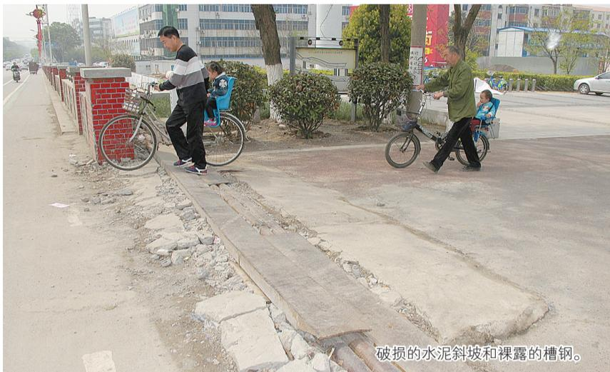
破损的水泥斜坡和裸露的槽钢。
