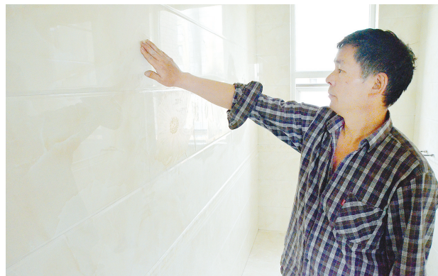
老柏仔细检查厨房墙壁上已经贴好的瓷砖，看看是否变形。
