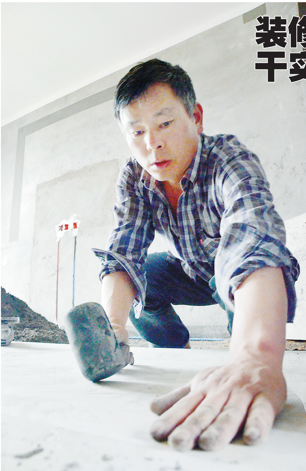
在老柏手中橡皮锤“砰砰”的敲击下，一块块地板砖便整齐地铺在了地上。
