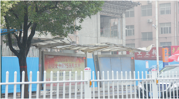
两个候车亭棚子严重变形,摇摇欲坠。
