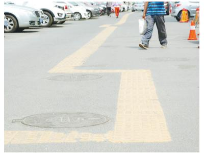
6月12日，一则“吉林现任性盲道，30米4个直角弯”的新闻在网络火爆传播，网上称吉林市街头上一排盲道很特别，几十米的盲道，曲曲折折，多个直角弯，凹凸有致的直角曲线，像迷宫一样。记者了解到，出现直角弯的盲道多是为躲避下水井盖。（新华网）
