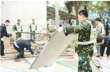
集中拆除违章建筑。
