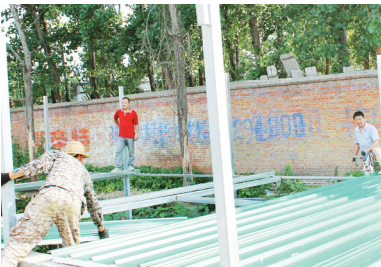
覆盖京铁路沿线污水沟。
