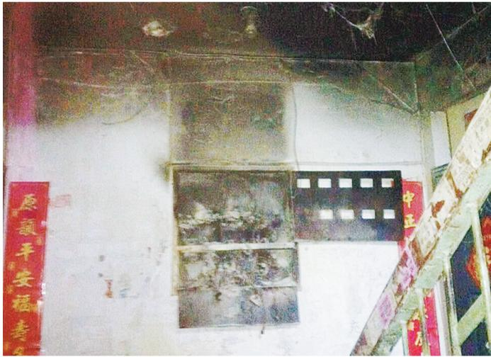
电表箱内电表已经烧没。
