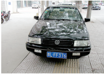
6月30日崂山路上占压盲道
