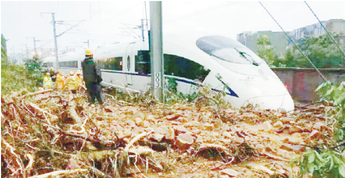
7月7日凌晨，南京南动车运用所至南京南站间线路塌方。
