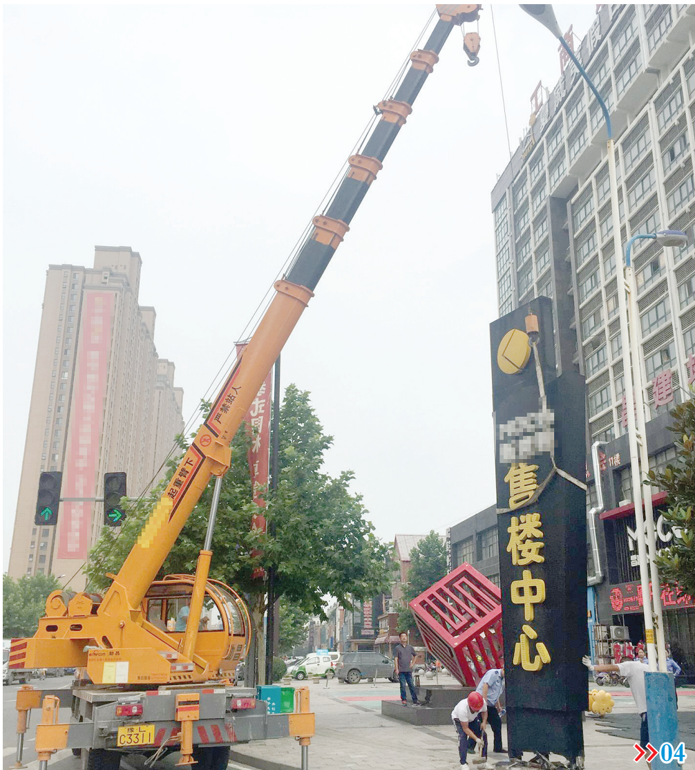
户外广告杂乱,严重影响市容市貌,7月9日至10日,市城建监察支队组织执法人员,对市区嵩山路、会展中心附近违法设置的大型立式广告牌进行集中拆除。 本报记者 王艳彬 摄
