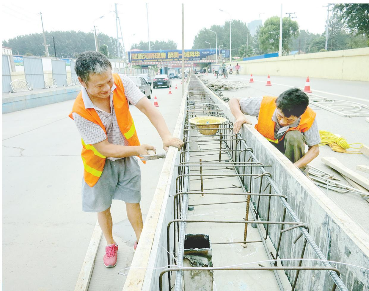
因建成时间过长,市区淞江路铁路立交桥涵洞两侧护栏锈蚀严重,如今不但起不到防护作用,而且存在一定安全隐患。昨日,市政部门开始对涵洞两侧护栏进行整修。 本报记者 王海防 摄
