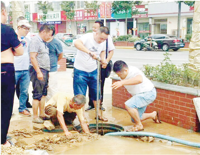
水管抢修工正在维修。
