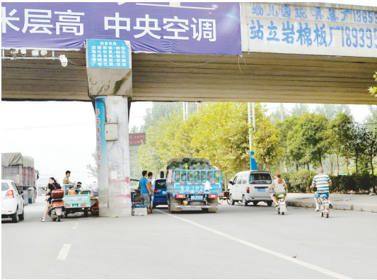
南洛高速立交桥涵洞下，商贩占道经营。
