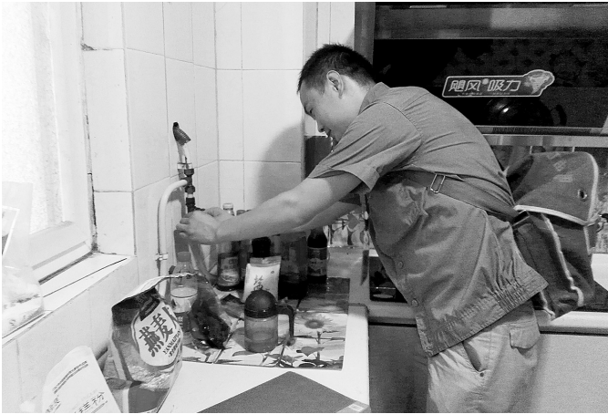
安检员正在检查管道。
