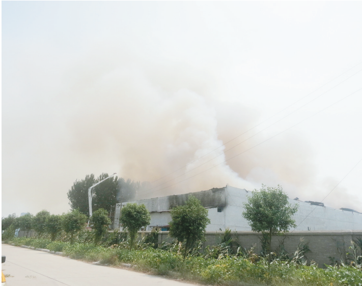
起火冷库上空，浓烟滚滚。
