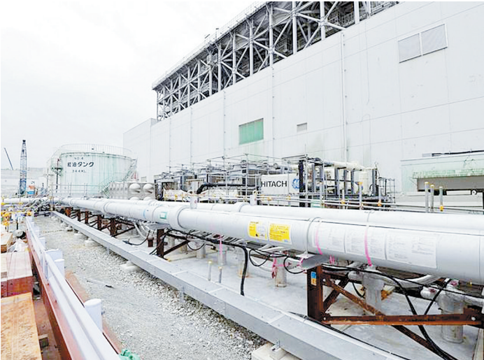
在日本福岛核电站，围绕受损反应堆修建的“冻土墙”隔离设施。
