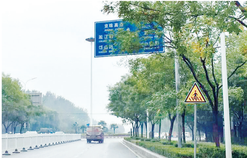
交通指示牌被枝叶繁茂的树木遮挡。
