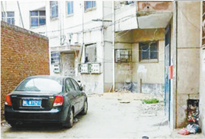
↑ 顺河街办事处泰山南路36号院整治后。
