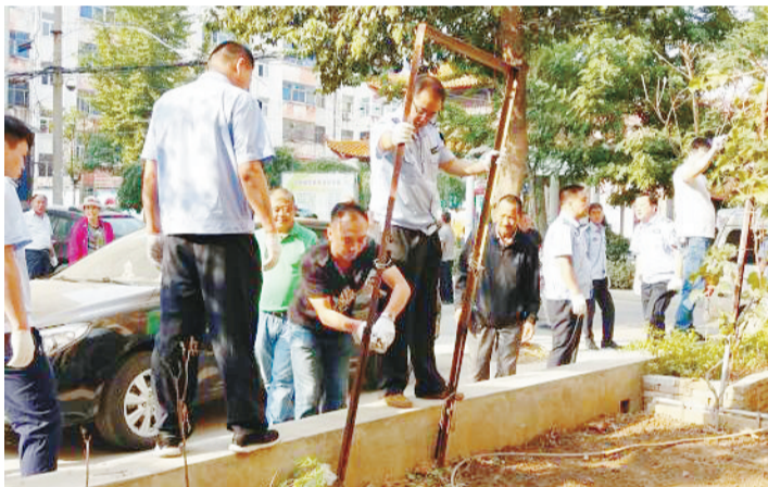
海河小区整治情况。
