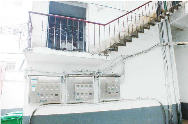
老旧家属院经过整治，电线整齐有序。
