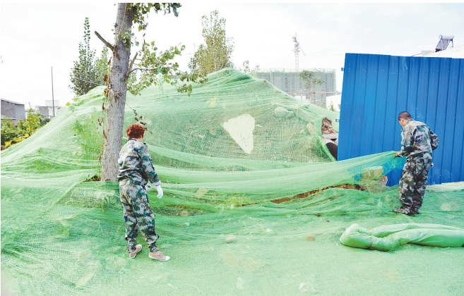
工作人员正在铺设防尘网。
