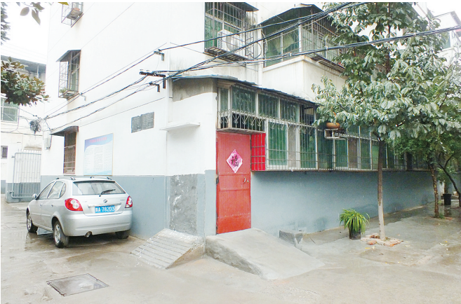
治理过后的小区干净整洁。
