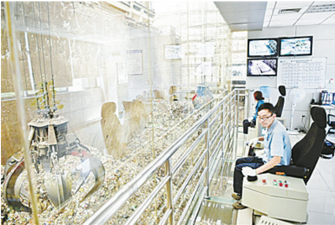
重庆丰盛垃圾焚烧发电厂工作人员在操作巨型机械手臂抓取垃圾。
