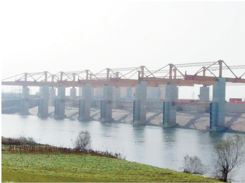
正在建设的漯河港。
