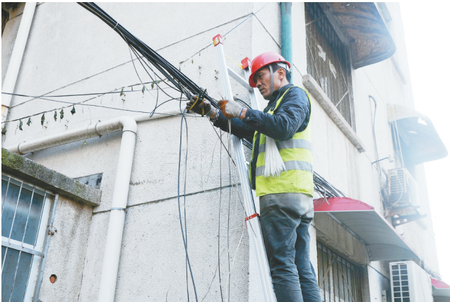
12月7日，在郾城区沙北街道黄山小区，一名电工正在整理小区杂乱无章的空中管线。目前，沙北办事处正在开展老旧小区空中管线整治行动，对辖区内老旧小区的空管线统一进行规范。 本报记者 王艳彬 摄
