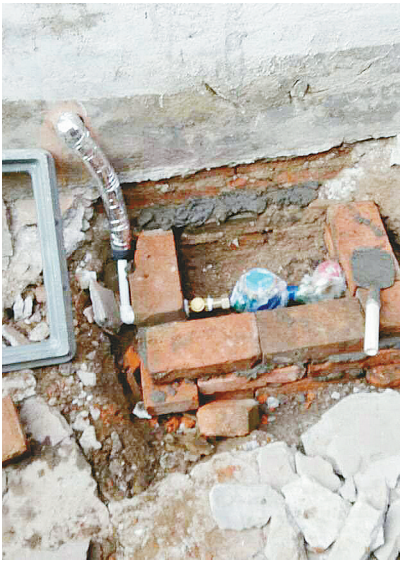
滨南巷部分居民家的水表已经安装完毕。 本报记者 于文博 摄
