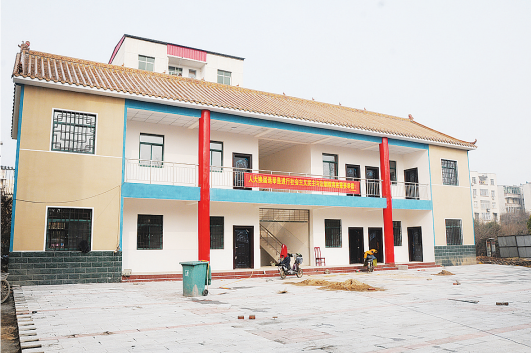
主体装修已经完成的泰山社区党群服务站。
