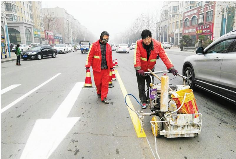
工人正在用划线机施划路面标线。
