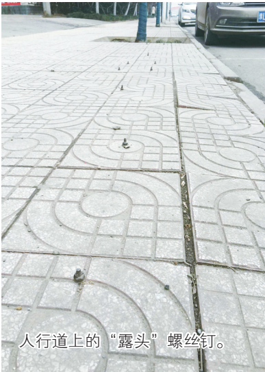
人行道上的“露头”螺丝钉。 些螺丝钉突出路面不多，如果不仔细看，很难发现。这些螺丝钉虽然不起眼，但附近居民遭了殃，多人曾被它们绊倒。
