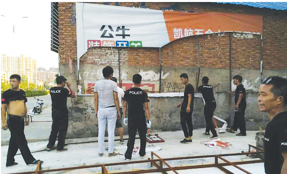
拆除废旧广告牌。
