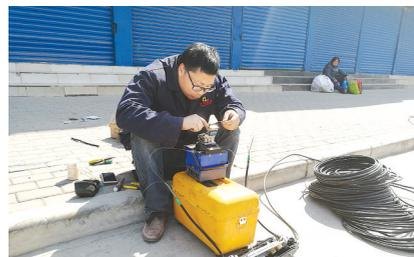
维修人员正在熔接光纤线缆
