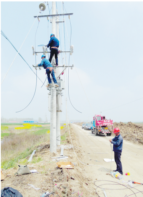
工人们正在村里安装电线杆，架高压线。
