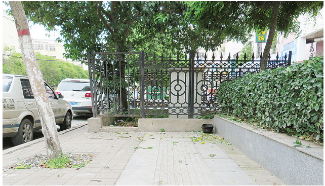
盲道被燃气设施阻断。
