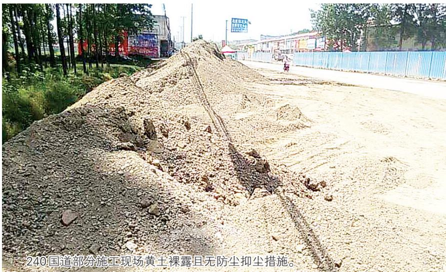
240国道部分施工现场黄土裸露且无防尘抑尘措施。
