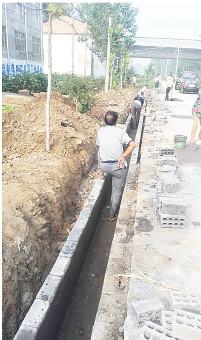
村里修建排水沟渠。
