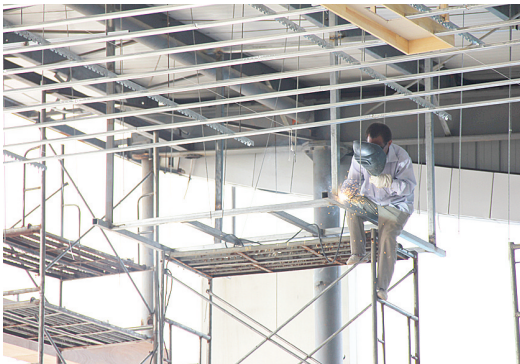
一家汽车4S店内，工人正在施工。
