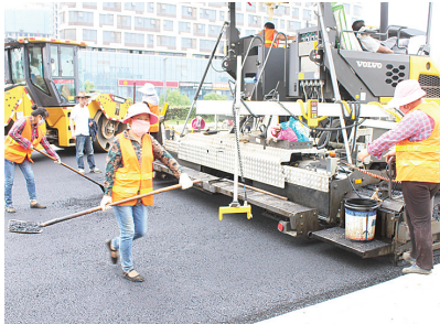
道路改造现场。
