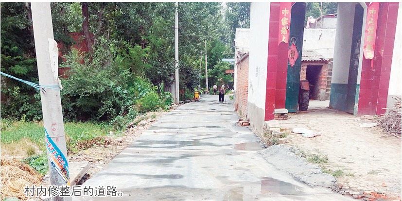
村内修整后的道路。
