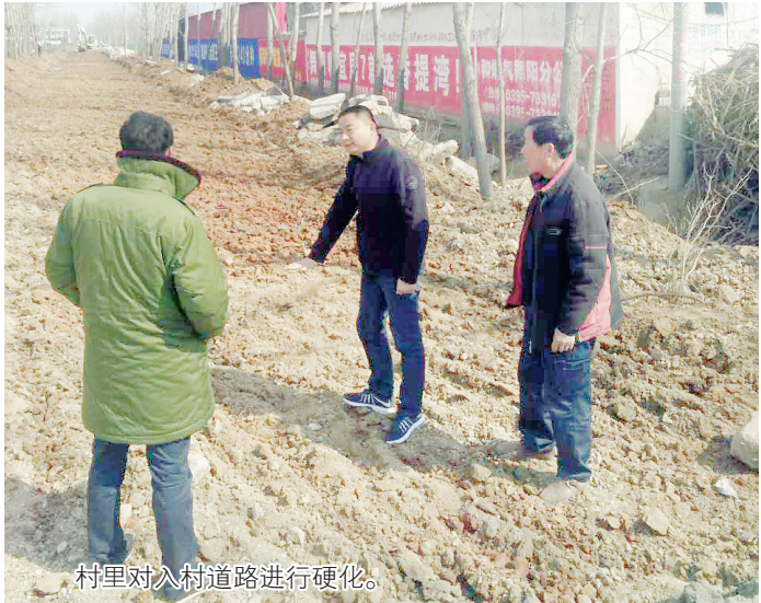
村里对入村道路进行硬化。
