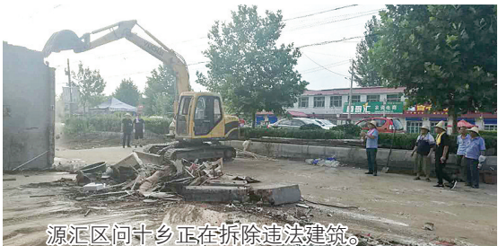
源汇区问十乡正在拆除违法建筑。
