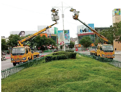
市路灯管理处清洁市区路灯。
