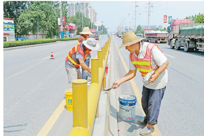
一路一风景，交通干线的好坏折射城市文明程度。为美化市区段干线路，市公路局组织人员来到白云山路，对隔离墩和护栏进行刷漆，更换安全标志。图为8月14日，工作人员对白云山路隔离墩进行补缺整理，以便刷漆。
