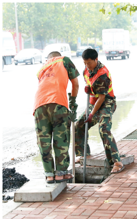
8月23日,在市区解放路南段,市建委组织人员疏挖下水管道。
