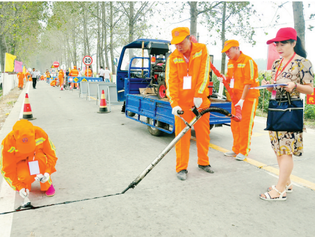
全市农村公路养护工职业技能大比武现场。
