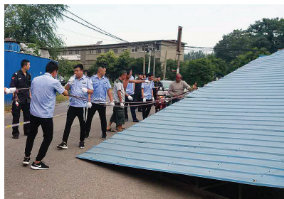
孟庙镇工作人员拆除辖区内的私搭乱建。
