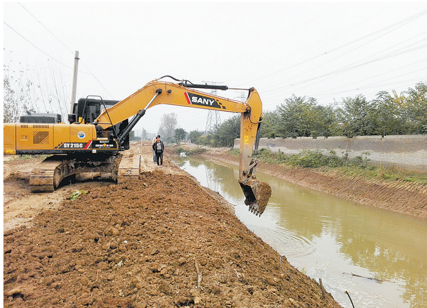
挖掘机的开挖渠道滩地。
