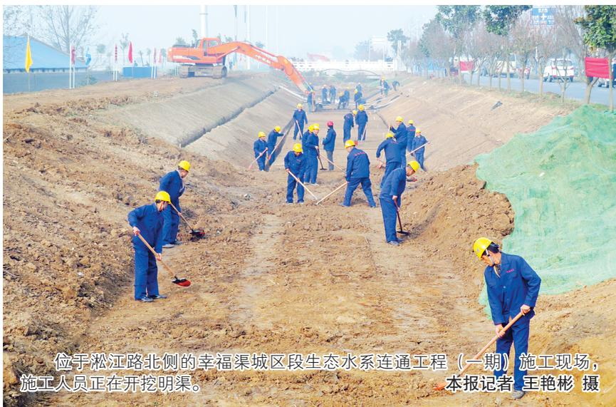
位于淞江路北侧的幸福渠城区段生态水系连通工程(一期)施工现场,施工人员正在开挖明渠。 本报记者 王艳彬 摄
